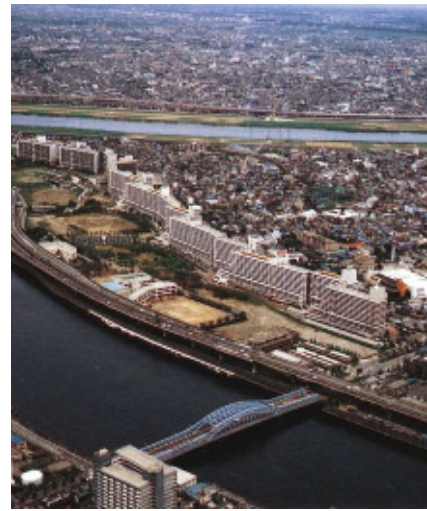
墨田区・白髭東第三地区 '81完成
