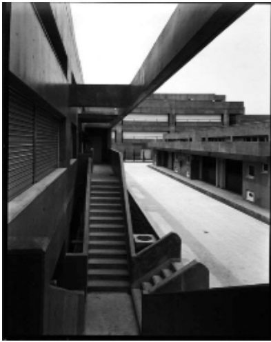
墨田区・白髭第二地区 '78完成
